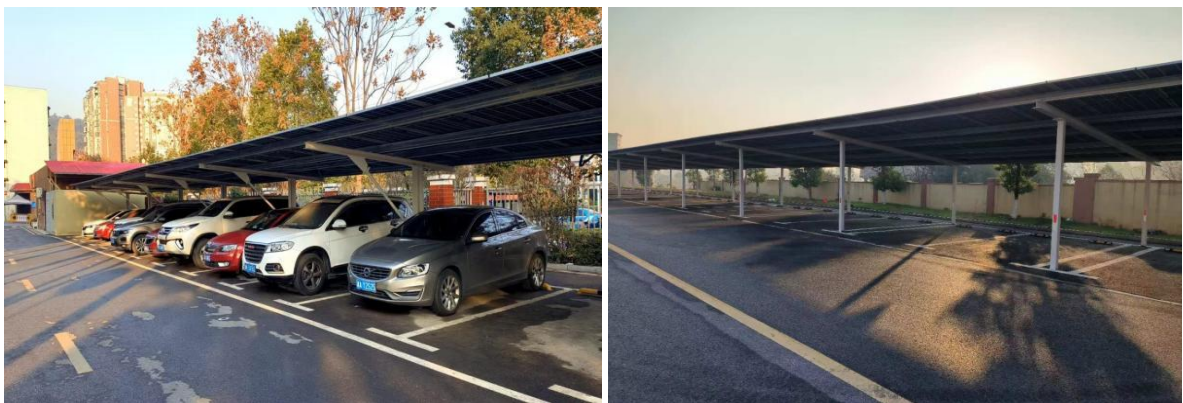
图 61 学校停车场与充电桩建设
