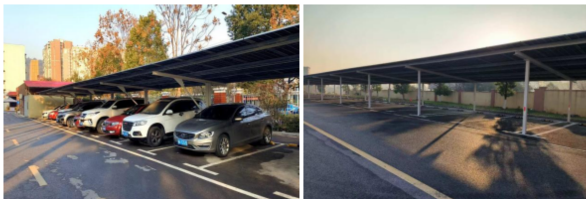
图 61 学校停车场与充电桩建设
